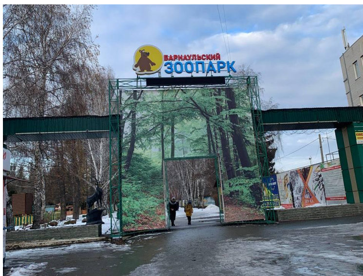
Рис. 1.130 Внешний вид конструкции входной зоны
